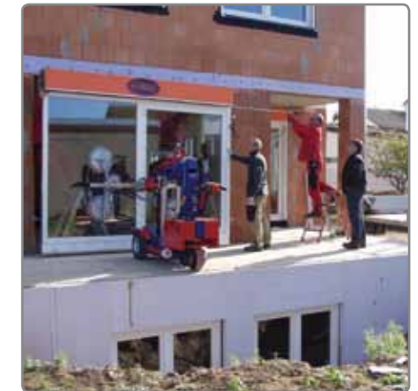
Auch bei beengten Platzverhältnissen ist der KS Robot 550 gut einsetzbar.
